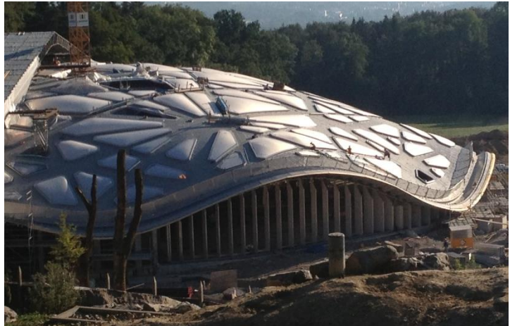
Dachkonstruktion im Bau (16.08.2013) | Bildquelle: Techdata AG
